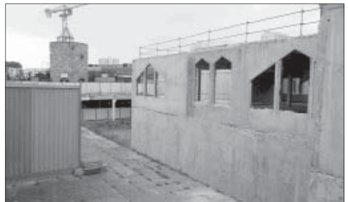
Chantier sur le lieu des futurs locaux de la Mda
