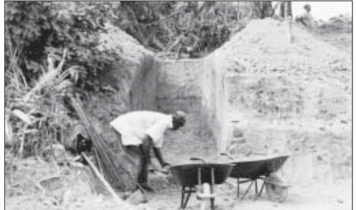
*Creusement d'une profonde tranchée pour y installer un four-tunnel*
