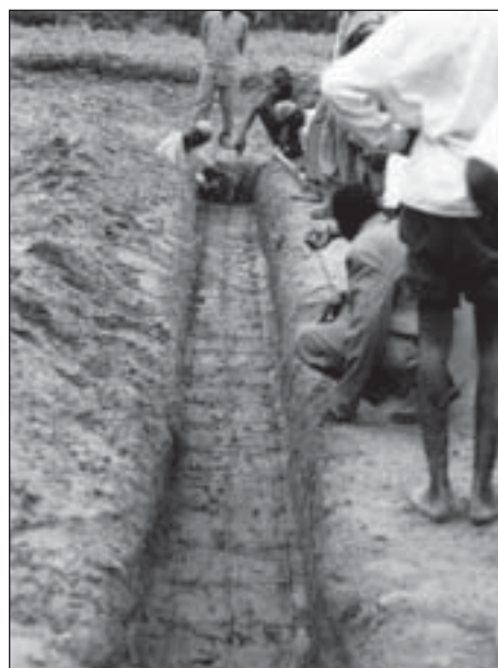
Les maçons du village posent les ferrailles au fond des fondations avant de couler le mortier.
