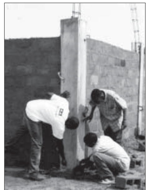
Nous apprenons comment faire un coffrage afin de couler les piliers. [ photos par M. Véchambre]
