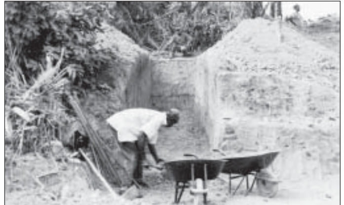
Creusement d'une profonde tranchée pour y installer un four-tunnel
