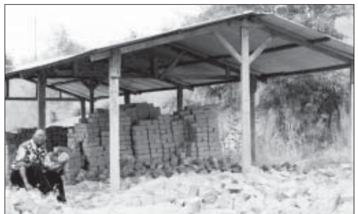
Briques de divers types prévues pour la construction d'un dispensaire
